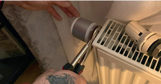
Abbildung 1: Technik der Zukunft: Die neuen, digital ansteuerbaren Thermostate des SECAI-Forschungsprojektes wurden in den teilnehmenden Wohnungen installiert.
